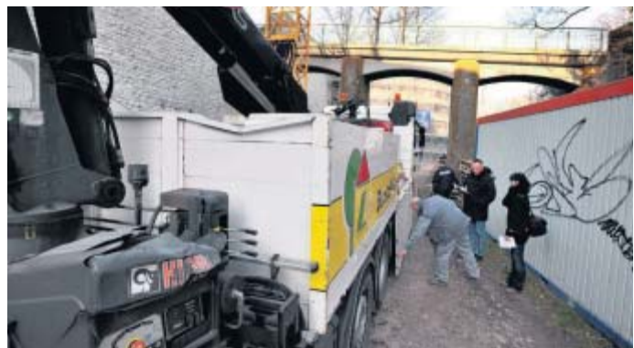
Größerer Schaden am Fahrzeug: Die Kranklammer fiel auf die Ladefläche und beschädigte den hinteren Teil des Lkw. FOTO: ANDREAS FRÜCHT
